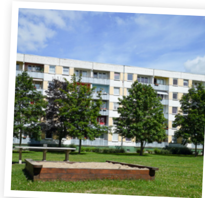
Blick auf das Wohnhaus 25-28
